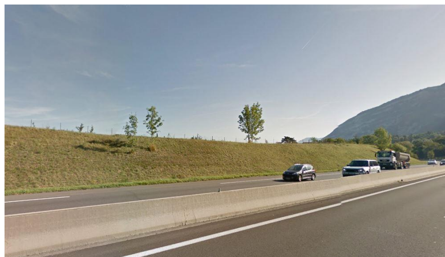
Le talus existant séparant l'A40 du périmètre de l'OAP Du Secteur Sur Plan, source, Google map
